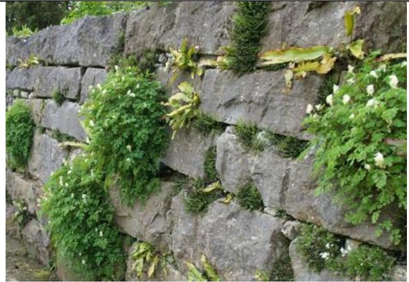
**Abb. 167: Trockenmauer (Lwg 2020b: 11)**
