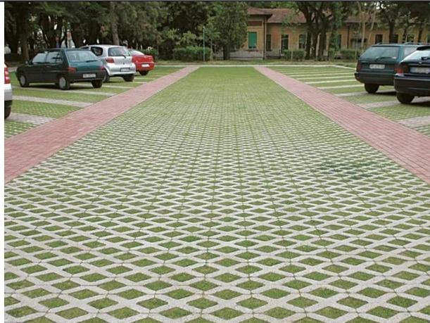
**Abb. 94: Beispiel für den Einsatz von Rasengittersteinen auf einem Parkplatz (ARCHIPRODUCTS o.J.: [www](http://www))**
