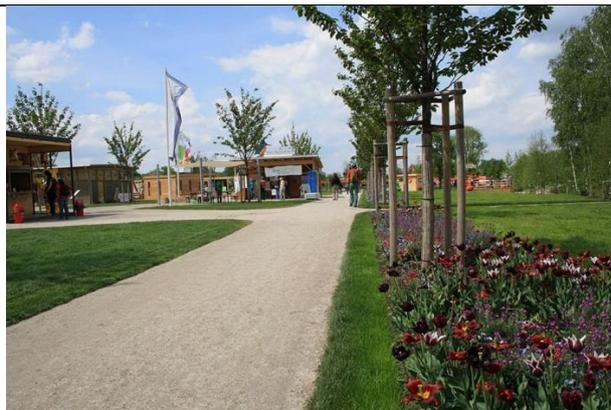
**Abb. 92: Beispiel einer Kies-Splitt-Decke bzw. wassergebundenen Wegedecke (HERMANN KUTTER GMBH & Co. KG o.J.: [www](http://www))**
