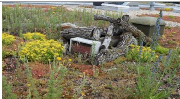
**Abb. 128: Extensivbegrünung die mit Biodiversitätsbausteinen aufgewertet wurde, hier eine Nisthilfe für Insekten, Berlin (MANN 2020: 1)**
