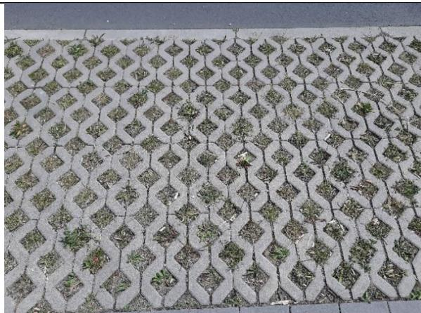
**Abb. 90: Teilentsiegelte Fläche im Planungsraum, Ausfahrt aus Rasengittersteinen an der Straße des Großen Freien (Eigene Aufnahme 10.05.2022)**
