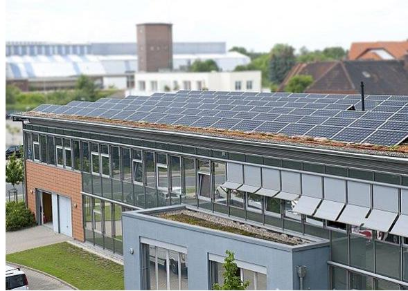
**Abb. 122: Dach der Stadtwerke Sehnde, Photovoltaikanlagen in Kombination mit extensiver Dachbegrünung (Sedum-Arten) (ENERGIEVERSORGUNG SEHNDE GMBH o.J.: www)**
