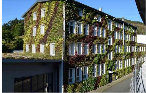
**Abb. 111: Wandgebundene Fassadenbegrünung, eine der größten „Living Wall“ Begrünungen Deutschlands, in Bad Laasphe an einem Ziegelmauerwerk (BUGG 2020: 26)**
