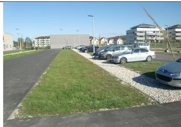
**Abb. 93: Beispiel eines Parkplatzes aus Schotterrasens (HYDROSAAT AG 2022: [www](http://www))**
