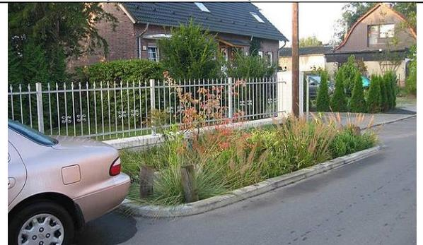
Abb. 69: Platzsparende Tiefbeet-Rigole mit Staudenbepflanzung (SIEKER o.J.: www)
